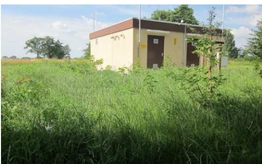
Abb.7 Pflanzenbewuchs an einer Gasanlage
