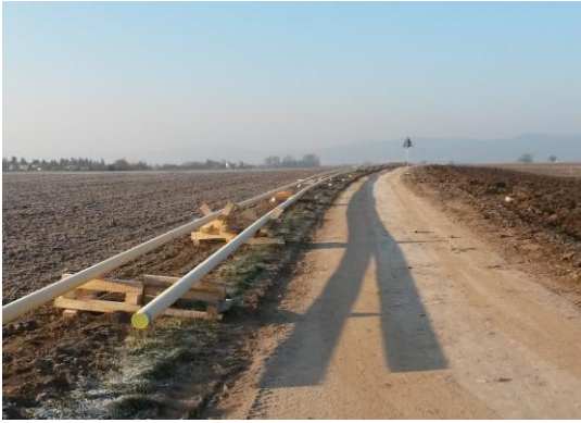
Abb.5 Neuverlegung einer Gashochdruckleitung
